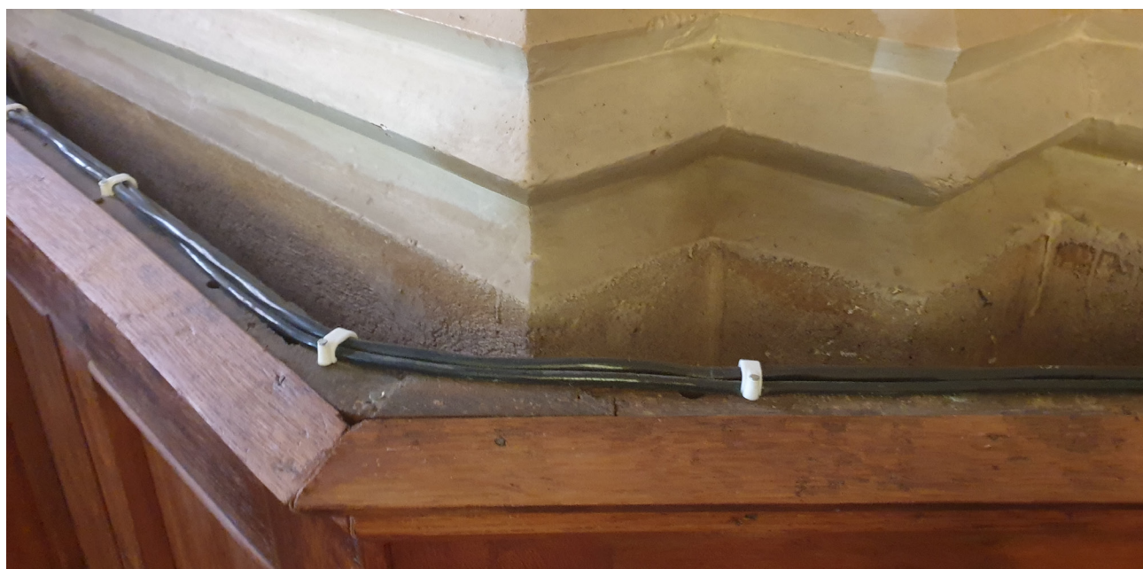
Polichromia w prezbiterium malowana tylko do wysokości boazerii drewnianej, co wskazuje na czas jej powstania po wykonaniu drewnianej zabudowy prezbiterium.
